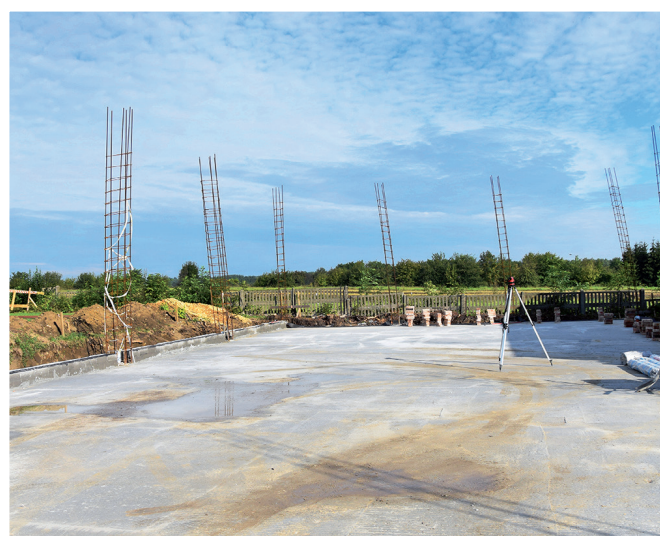
RUSZYŁA BUDOWA SALI GIMNASTYCZNEJ W PRZECZYCACH (str. 4)
