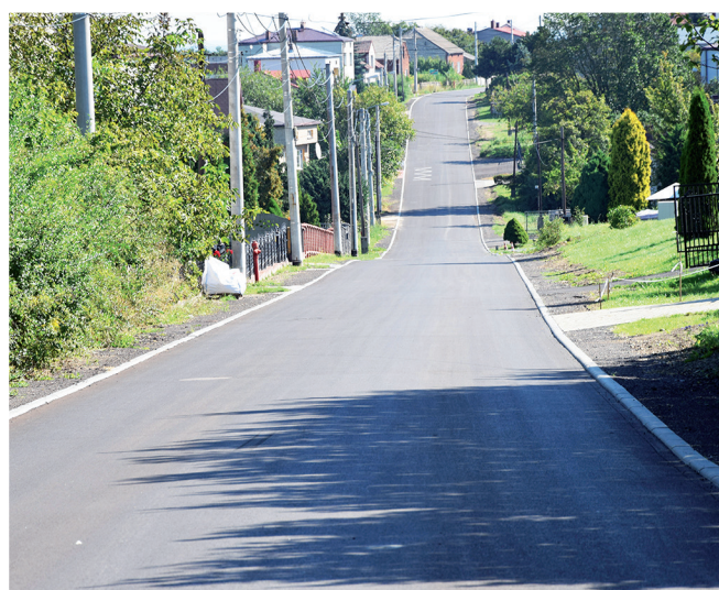
UKOŃCZONO PRZEBUDOWĘ DROGI POWIATOWEJ 4756 S (str. 4)
